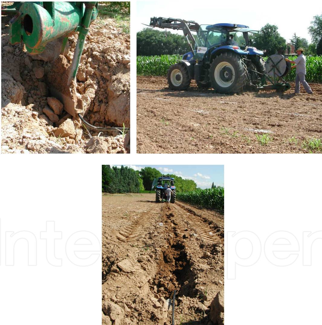
Fig. 4. Installation of SDI.
